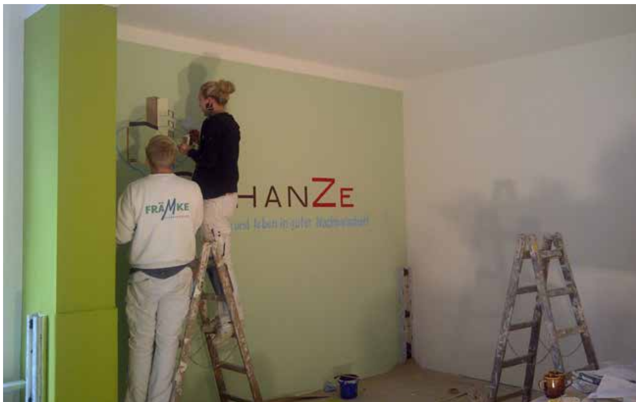
Handwerksbetriebe engagieren sich oftmals durch Pro-Bono-Leistungen. Eine Win-Win-Situation ist in Bad Oldesloe-Schanzenbarg entstanden, wo die Umbauarbeiten an einem Nachbarschaftszentrum als Lehrbaustelle der Ausbildung dienen.
